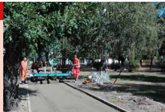
Chodnik w trakcie budowy
